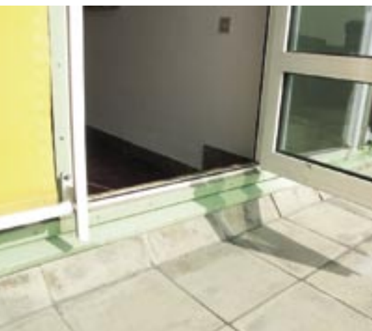
Eine nahezu ideale Ausführung zeigt dieser Ausstieg auf eine Dachterrasse
