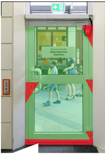
Das Bild zeigt die Risiko-Bereiche einer Tür, wenn sie nur sensorisch auf der Bandseite abgesichert ist.
