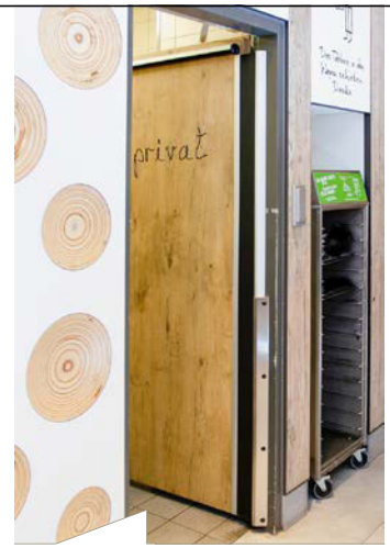
Hier eine kraftbetätigte Gastronomie-Tür mit Athmer Fingerschutz NR-32 UniSafe und zusätzlichem Rammschutzelement.
