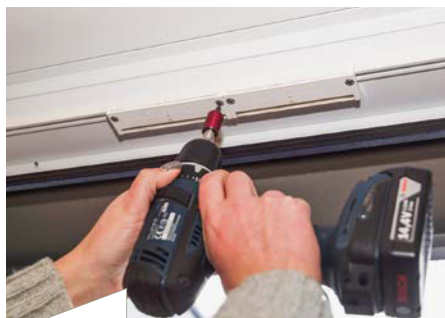
Mit einem einfachen Akkuschauber lassen sich die je zwei Schrauben eines Fensterfalzlüfters lösen.
