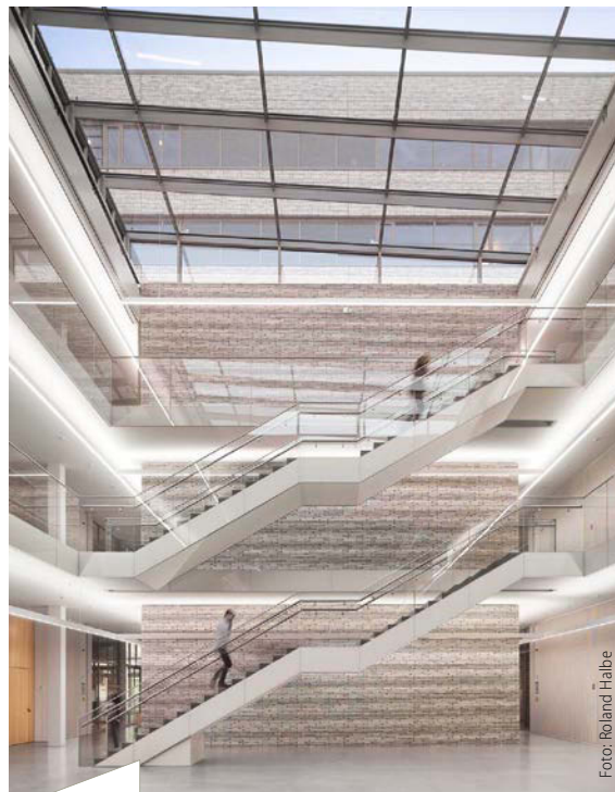
Die gesamte Absturzsicherung zum Atrium und bei den geschossverbindenden Treppen besteht aus Glaselementen.
