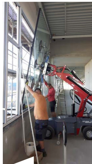
Monteure können den Glassworker beim Einbau von Fenstern und Türen im Innen- und im Außenbereich einsetzen.
