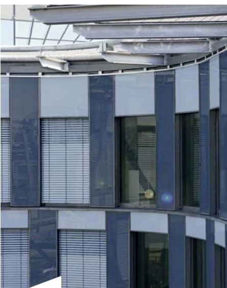
Mit der Tageslichtfunktion der Raffstoren wird der Lichteintrag in den Büros gesteuert.
