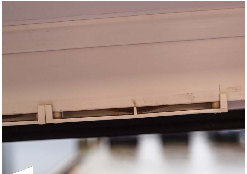
Eine einfache Sichtkontrolle zeigt, dass sich bereits einige Ablagerungen in dem Fensterfalzlüfter gebildet haben.
