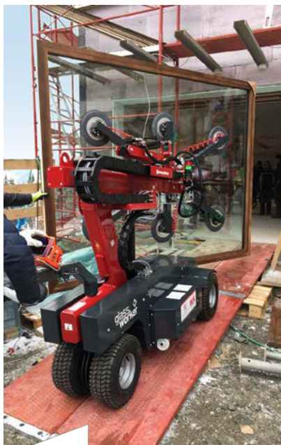
Der Glassworker von Uplifter dient zum Transport und zur Montage von schweren und schweren Glas- und Fensterelementen auf der Baustelle.
