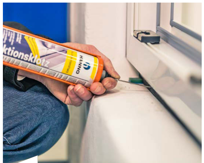
Der Hanno-Injektionsklotz lässt sich anhand einer Kartuschenpresse einfach in das Abdichtungsband einspritzen.
