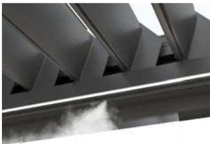
● **ERFRISCHUNG:** Ermöglicht, dass das Wasser mittels eines Hochdruckpumpensystems Druck aufbauen kann, wodurch – durch spezielle Düsen – ein ultrafeiner Nebel entsteht, der für eine Temperatursenkung im betroffenen Bereich sorgt;
