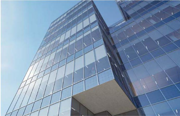
„Stopray Active“ kombiniert Solarzellen mit einem Magnetron-Coating und lässt sich perfekt auf Stopray Vision Gläser abstimmen. Für Fassaden bedeutet das homogene Flächen, die zudem Energie erzeugen.
