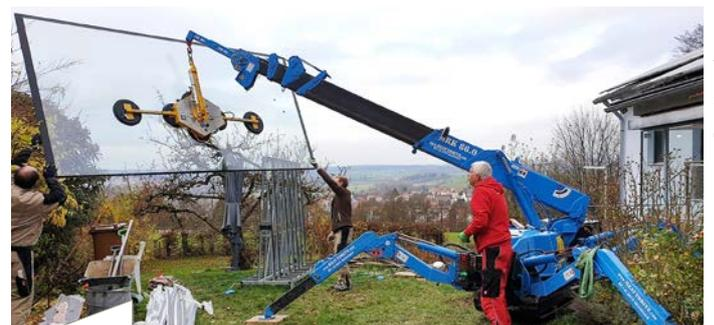
Kurz vor dem Einbau; Das Ansaugen einer 200 kg Scheibe mittels Heavydrive MRK 86.0 mit Montagespitze.
