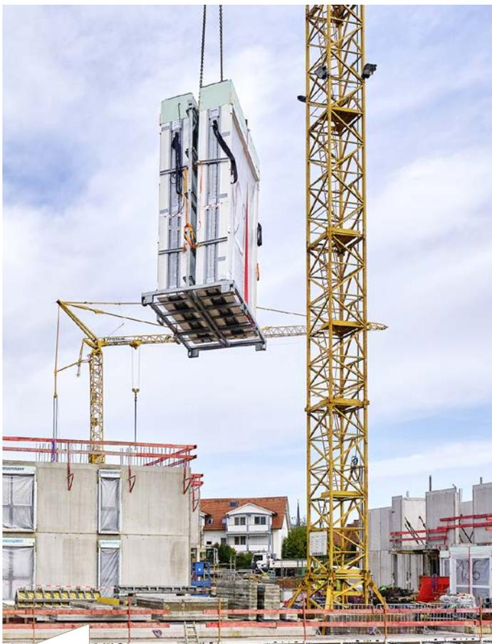
**Kein Schleppen, keine teuren Hubsysteme. Windowment schwebt per Kran direkt an den Ort der Verarbeitung und wird einfach mit eingemauert – als ein großer Baustein.**
