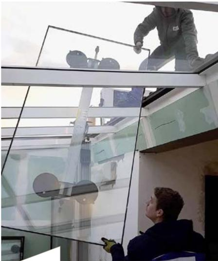
**Mit dem Scheibenlift TGT EasyLift/XL können zwei Monteure selbst schwere Scheiben in Dachkonstruktionen und bei Wintergärten einlegen.**
