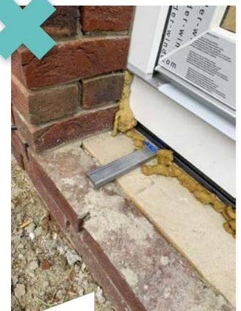
Falsch: Eine untere Lastabtragung über ein Eisenrechteckrohr, das auf der Rohbetonplatte und dem Vorsatzmauerwerk lose aufliegt, ist nicht im Sinne einer geeigneten Lastabtragung anzusehen.
