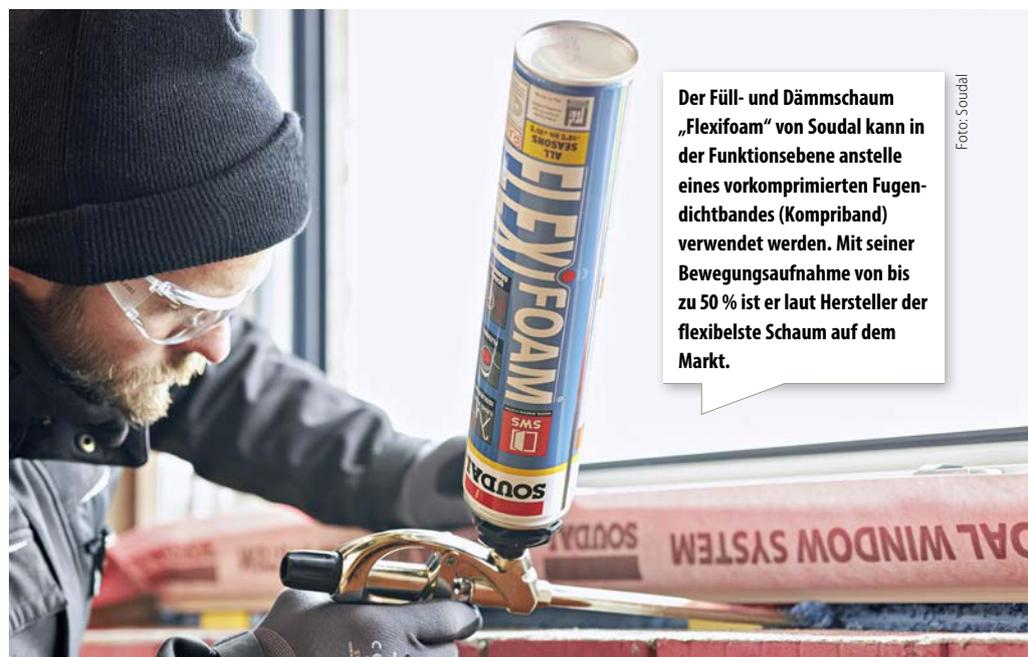
**Der Füll- und Dämmschaum „Flexifoam“ von Soudal kann in der Funktionsebene anstelle eines vorkomprimierten Fugendichtbandes (Kompriband) verwendet werden. Mit seiner Bewegungsaufnahme von bis zu 50 % ist er laut Hersteller der flexibelste Schaum auf dem Markt.**
