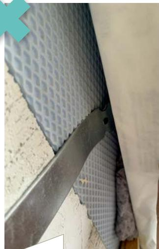
Falsch: Ein Verschrauben in der Dämmebene selbst gibt dem Element keinen Halt.
