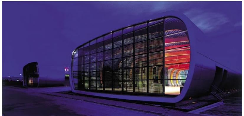
SSG-Fassade mit semitransparenten Isolierglasmodulen
