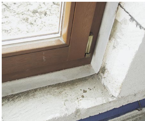
Die innere Fugenabdichtung hat endlich Eingang in die ATV Tischlerarbeiten gefunden. Hier ist ein Holzfenster mit einer Bauanschlussfolie auf Porenbeton gezeigt
