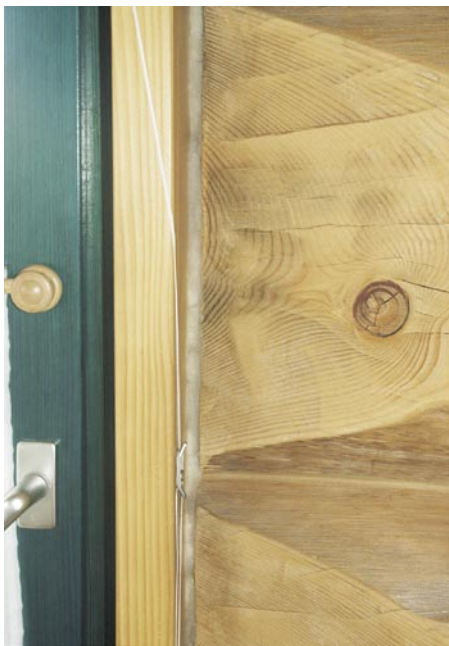
Mineralwolle („Mineralfaserdämmstoff“) als Fugendämmung bei einer Blockhauszarge
