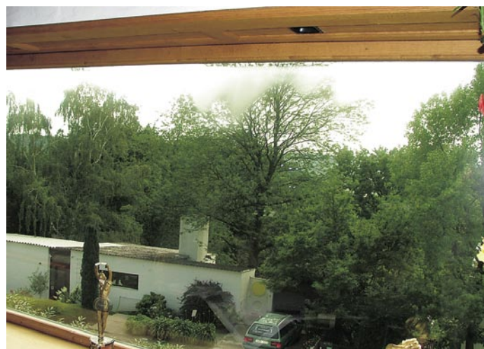
Bild 1: Bereits ohne Abkühlung sind Kondensatfelder an der Fensterfront zu erkennen
