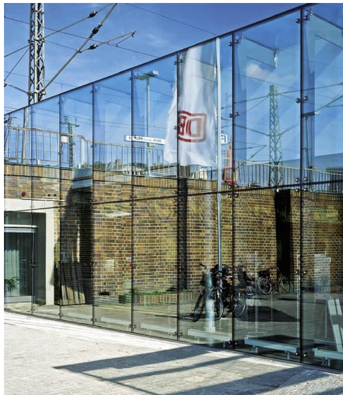
Vertikalanwendung: Punktgehaltene Fassade
