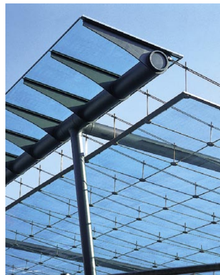
Punktgehaltene Bedachung an gespannter Drahtseilkonstruktion
