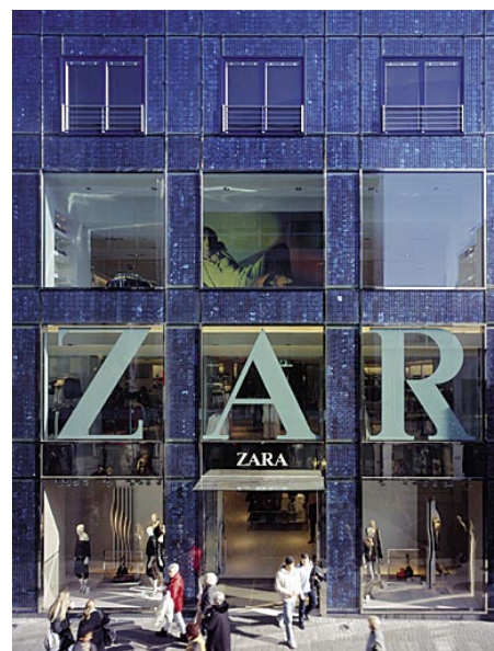
Photovoltaik-Fassade mit „Solon“-Modulen am Modehaus Zara in Köln
