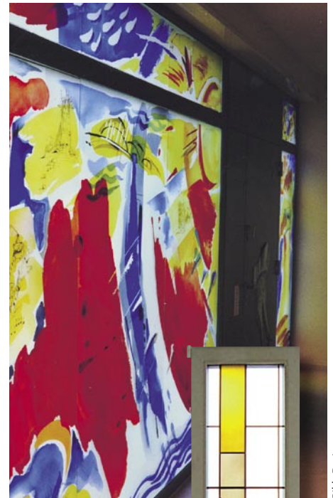
Entwurf von Gerda Laufenberg: Echtantikgläser vor Alarm-Securit-Glas – glas-malerisch und ätztechnisch bearbeitet dazu intarsienmäßig eingeschliffen
