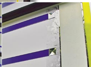
Entwurf von K.-H. Traut: Mit Sandstrahltechnik gestaltetes Isolierglas als partieller Sichtschutz – aufgeklebte Echtantik-Überfang-Gläser in weichem Verlauf abgeätzt
