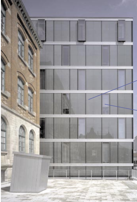
Bild 3: Das Landesdenkmalamt in Esslingen ist mit der neuen Retro-Technik ausgerüstet – g-Wert 0,08
