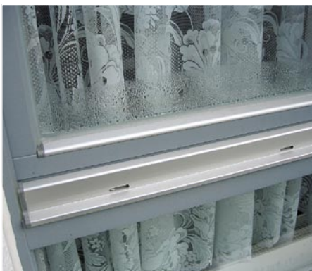
Schutzschienen gegen UV-Strahlung auf den gefährdeten Stellen
