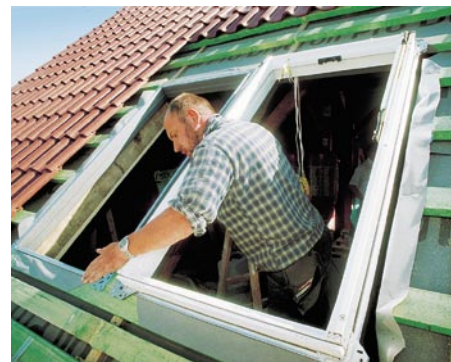
Die umfassende Vormontage ab Werk erleichtert den Einbau des Fensters für den Fachhandwerker
