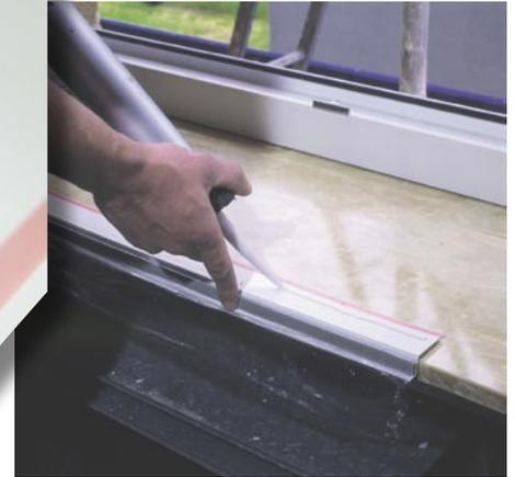
Der Montagekleber wird auf der Innenseite der Leiste aufgebracht. Bis er anzieht und die Leiste mit dem zuvor gereinigten Blendrahmen verbindet, wird diese mit Hilfe der Selbstklebung fixiert. Der Schutzstreifen wird dann abgezogen
