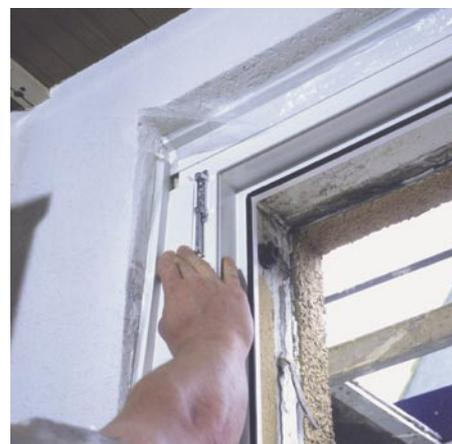
Für die Eckausbildung wird die Anschlussleiste mit der Schere entsprechend ausgeklinkt und ebenfalls mit der Selbstklebung am Blendrahmen fixiert
