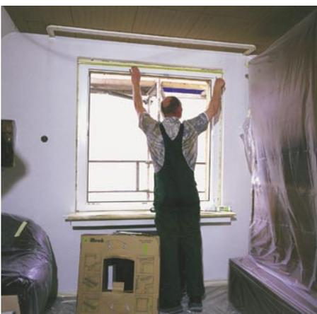
Die mittlere Abdichtungsebene der Fenster wurde zur Wärme- und Schalldämmung vollständig ausgeschäumt. Anschließend erstellt der Monteur das Aufmaß
