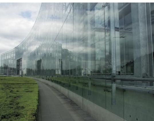
Derartig als 2. Haut vorgehängte Glasfassaden benötigen allenfalls für einzelne Merkmale eine CE-Kennzeichnung
