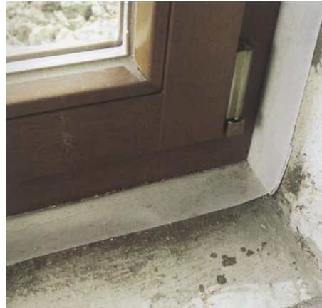
Beispielhafte Darstellung einer Folienverklebung als Detailschnitt (links) und Bild
