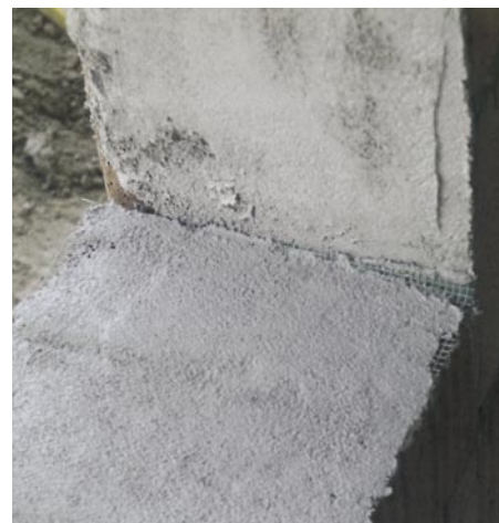
Bild rechts: Rohbausituation nach dem Glattstrich
