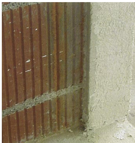
Bild links: Rohbausituation vor dem Glattstrich
