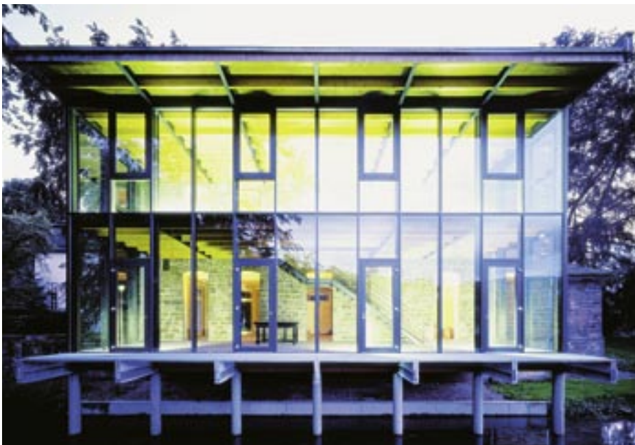
Funktionssicherer Sonnenschutz löst den Zielkonflikt zwischen winterlichen solaren Energiegewinnen und Begrenzung der Sonneneinwirkung im Sommer
