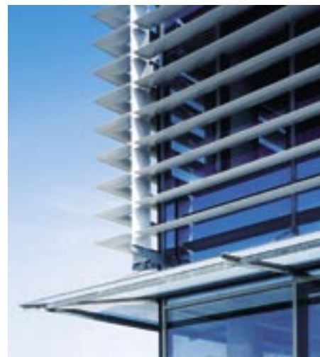
In der Starre durchaus beweglich: Großlamellen-Sonnenschutzsystem
