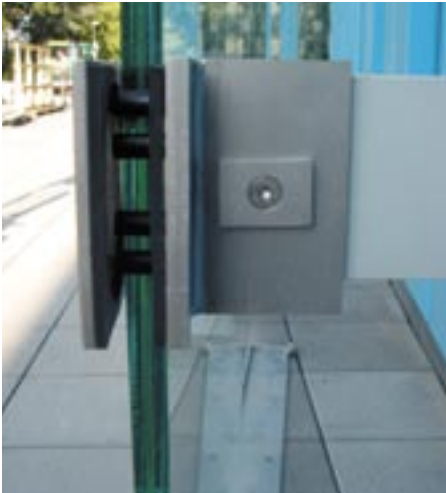
Zwischen die Aussparungen wurde ein Winkel aus Spezialkunststoff eingefügt.
