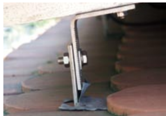
Die Montage erfolgt mit einfachen Mitteln
