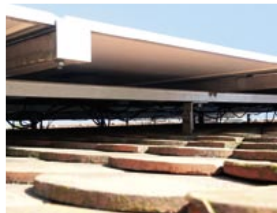
„Untersicht“ einer Montage-Situation auf einem Ziegeldach
