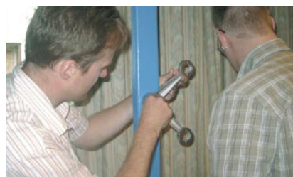
Montage eines punkthaltigen SGG-Multi-point-System
