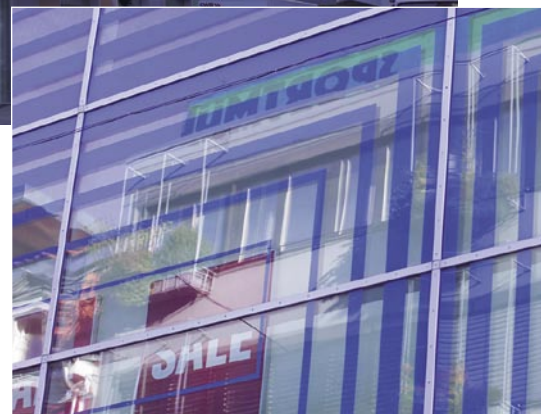
Detail der im Blauton bedruckten Westfassade
