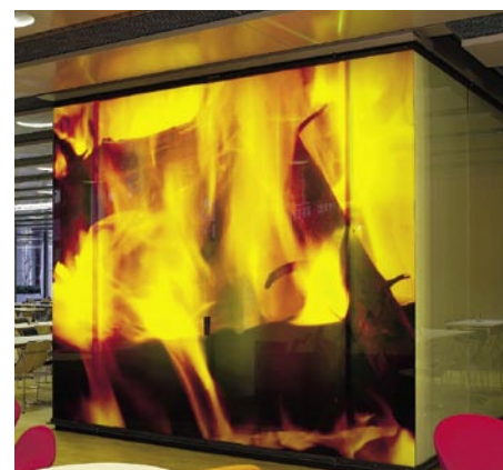
Glaskubus, der als hinterleuchtete Kaminwand einen Versorgungsschacht umhüllt
