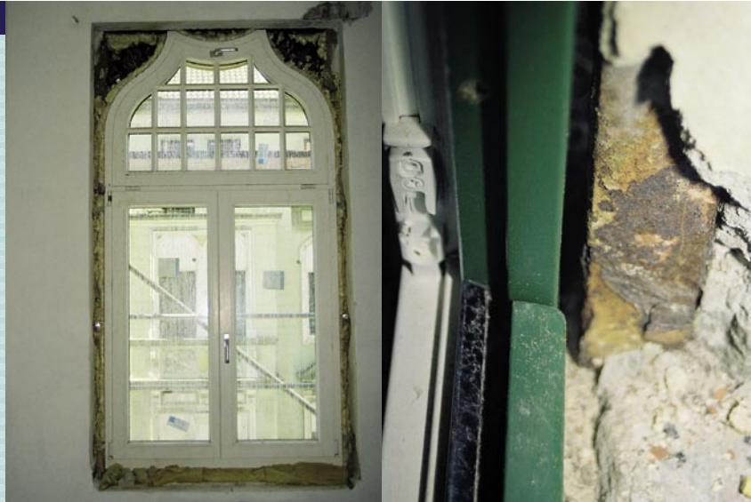
Bild links: Blendrahmen müssen den Freiraum ausfüllen
