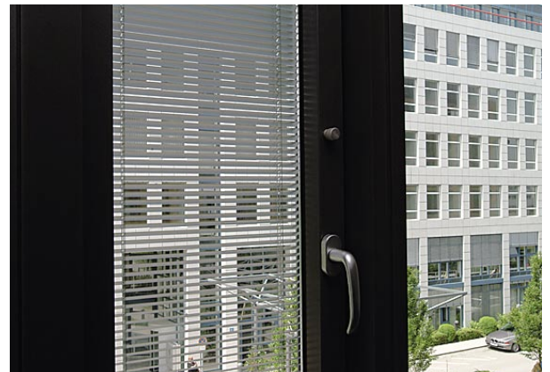
Der Sonnenschutz ist zugleich Bestandteil der Fassadengestaltung
