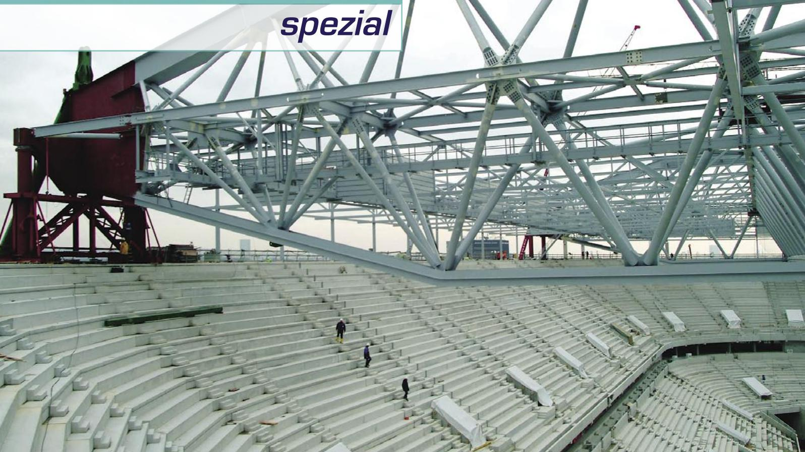
Stützenfreie Dachkonstruktion aus warm gefertigten „MSH“-Profilen bei der LTUarena in Düsseldorf
