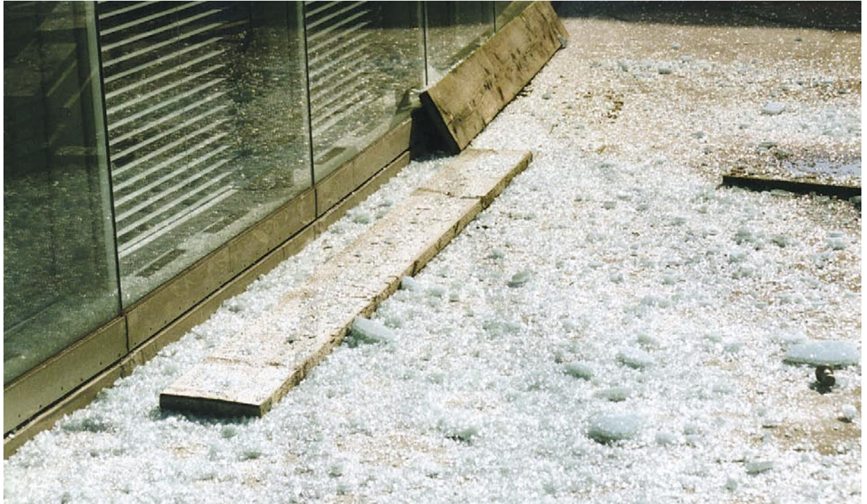
Glasbruch kann unter anderem auch durch Zwängungen aus der Konstruktion erfolgen
