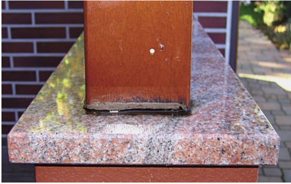
Kaschierung der Holzflächen mit ausgenuteter Leiste
