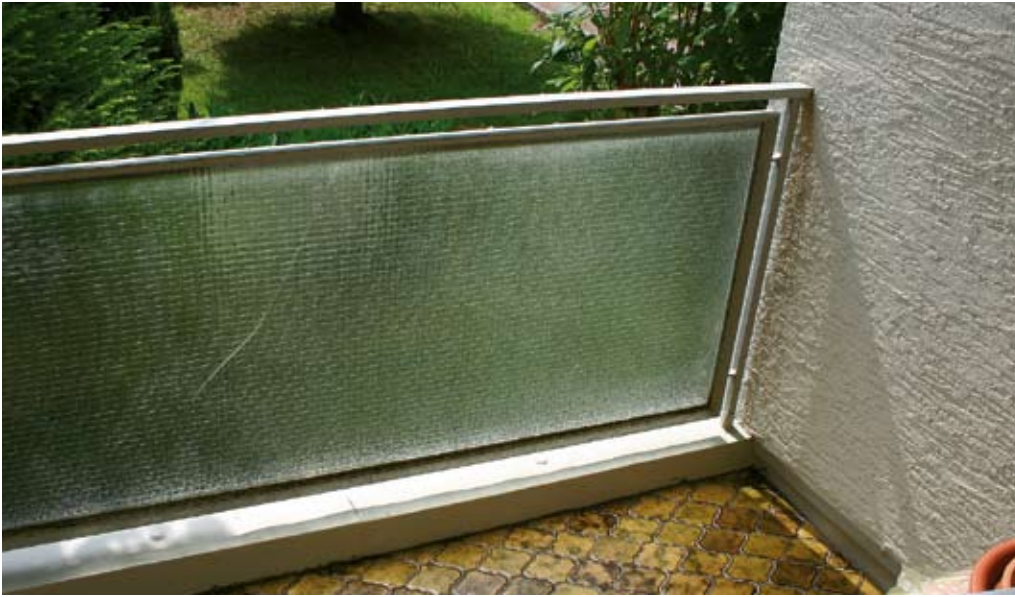
Ansicht der Verglasung einer der Drahtglasscheiben
