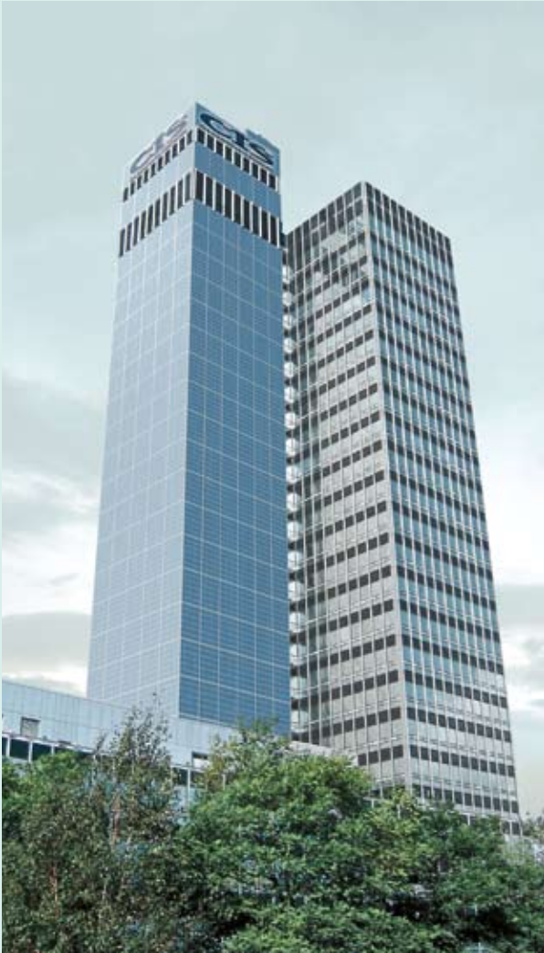
Fassadenintegrierte PV-Anlage: Der CIS-Tower in Manchester (GB) wurde von Sharp Solar realisiert und war zum Zeitpunkt der Einweihung die höchste PV-Fassade Europas
