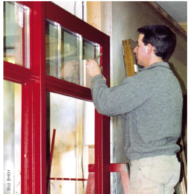
Vorteil für Fensterbauer und Montage-Betriebe: Künftig können sie beim Einbau von Fenstern sowohl Ortschaum als auch Mineralfaserdämmstoff zur Dämmung verwenden
