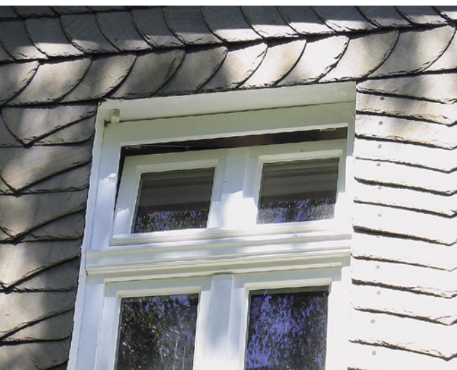
Oben links gut zu sehen ist der Fixierkeil im Spalt
