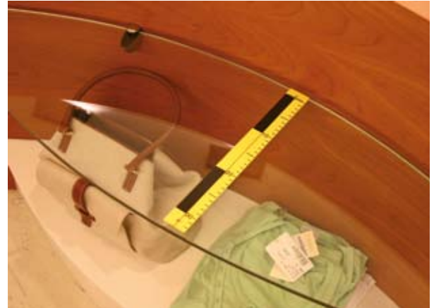
Ansicht der Regalscheibe mit Tiefenabmessung
