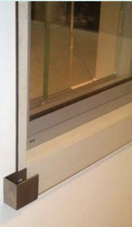
Bei „BlastShield“ schützt eine auf speziellen flexiblen Lagerungen ruhende Verbundsicherheits Scheibe das dahinter liegende Fenster vor der Druck-/Sogwirkung der Druckwelle
