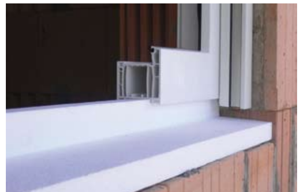
Drei Abdichtungsebenen in einem Produkt: Am Fensterfußpunkt werden mit dem Fensterbankformteil Wärmebrücken und Tauwasser vermieden und zusätzliche Arbeitsgänge für die Abdichtung eingespart
