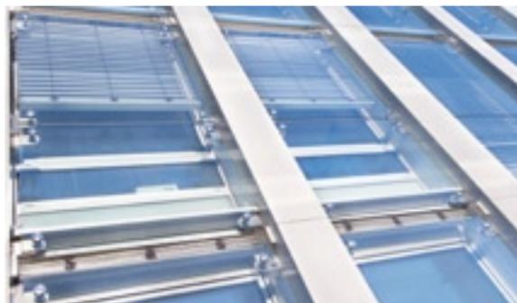
Die äußeren Elemente sind geschossweise geschottet und aufgrund ihrer reduzierten Größe rundum hinterlüftet; jeweils im oberen Bereich des Zwischenraums sind die elektronisch gesteuerten Sonnenschutz-Jalousien witterungsunabhängig gelagert
