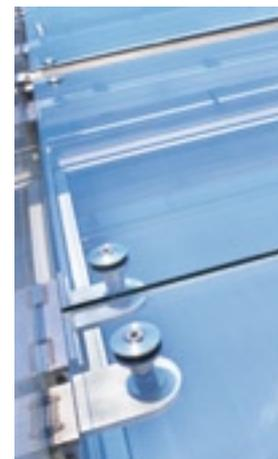
Das Fassadendetail zeigt die beschlagtechnische Sonderlösung: Speziell entwickelte Edelstahlcharniere, befestigt an den wärmege dämmten Lisenen, ermöglichen das Einschwenken der VSG-Elemente zu Reinigungszwecken
