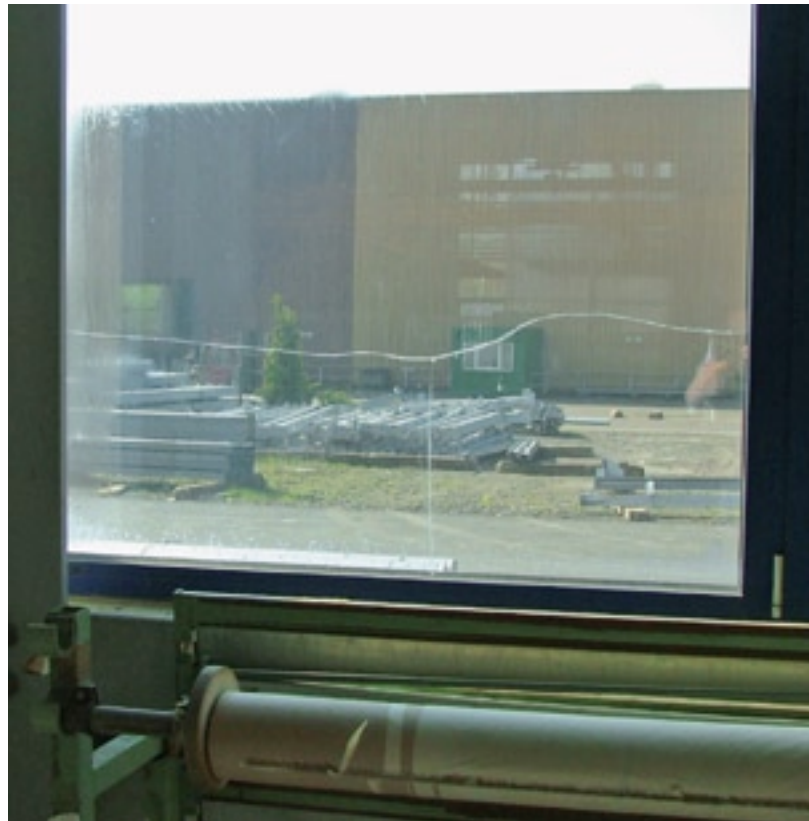
Bild 6: T-förmiger Glassprung, im rechten Winkel von den Glasdeckenleisten ausgehend
