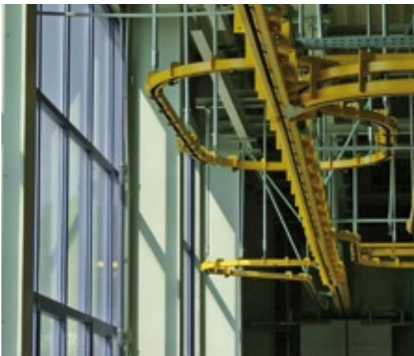
Bild 5: In relativ kurzem Abstand, teils unter einem halben Meter von den Isolierglaseinheiten entfernte Deckenlaufschienen
