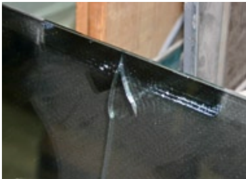
Bild 4: Detailansicht des Rissbeginns im Bereich der aufgesteckten Lampe
