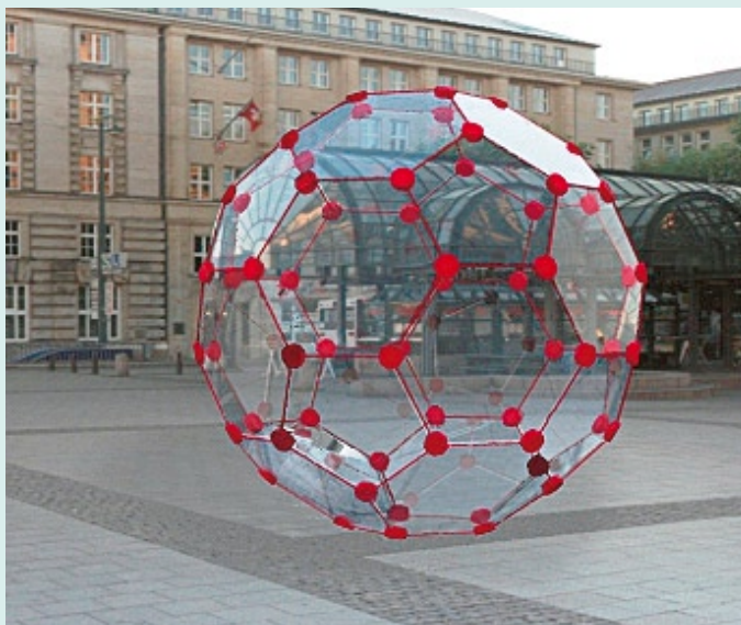
Der 2,40 m große „Glasfußball“ in Stahlglasbauweise.
