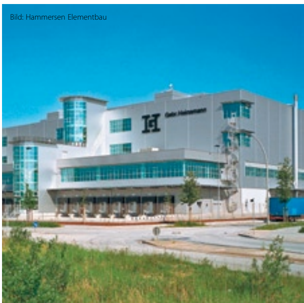
Aufgrund seiner physikalischen Eigenschaften hat Stahl als Baustoff eine große Zukunft, im Bild das Logistikzentrum Gebr. Heinemann in Hamburg-Bergedorf
