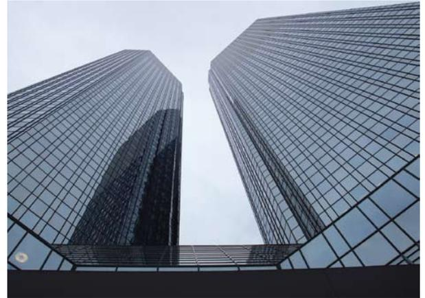
**Gebäude der Deutschen Bank in Frankfurt (Hanig, Scheid und Schmidt, 1984) mit einer Sonnenschutzverglasung aus verspiegeltem Glas. Die Glashalteleisten geben eine Struktur – im Gegensatz zu geklebten Fassaden**
