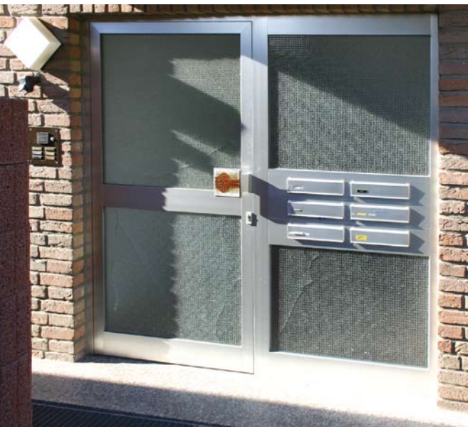
Bild 1: Gesamtansicht der Eingangsanlage
