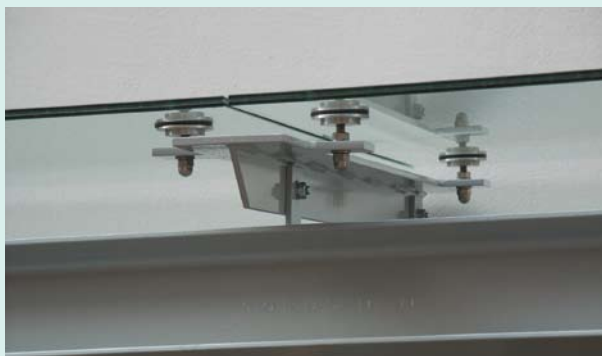
Klassischer Fall: Solche Verglasungen sind von der Regel voll abgedeckt
