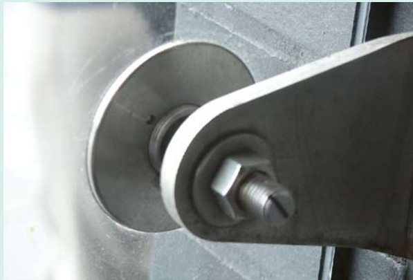
Punkthalter, der nach Technischen Baubestimmungen rechnerisch nachgewiesen werden kann
