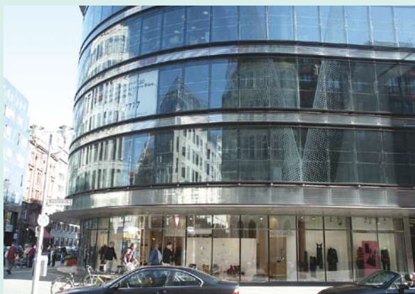
Gebogenes ESG mit Punkthaltern in dieser Art ist nicht freigestellt
