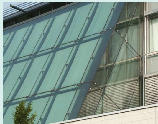
Randklemmhalter für Überkopfverglasungen sind nicht geregelt
