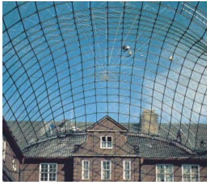
Das Glasdach für das Museum für Hamburgische Geschichte ist die denkbar feingliedrigste und optisch leichteste Konstruktion als Wetterschutz für den Innenhof und als volltransparente Schale ein konstruktiver Meilenstein (Architekten: von Gerkan, Marg & Partner, Hamburg) Foto: Klaus Frahm
