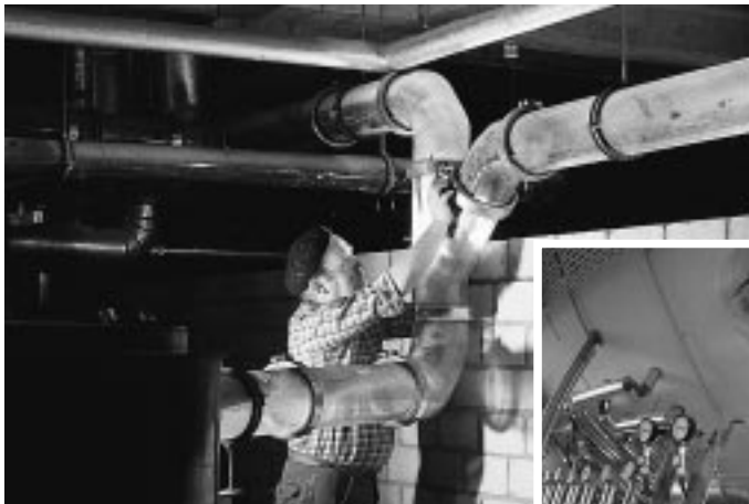
Glasrohre im Kreiskrankenhaus Worms
