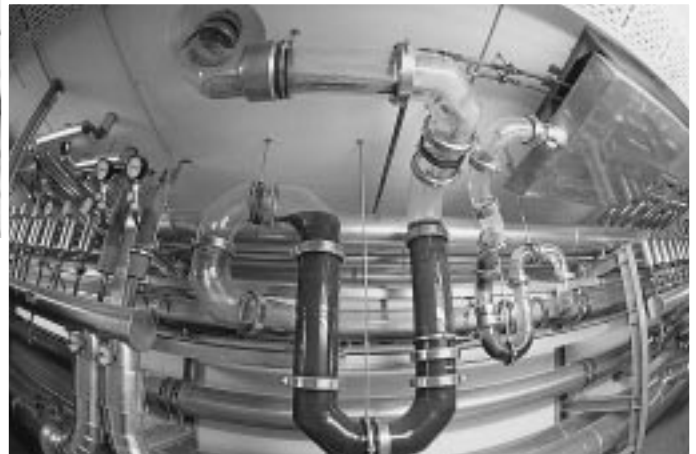
„Glas-Installationen“ dank „Boresist“
