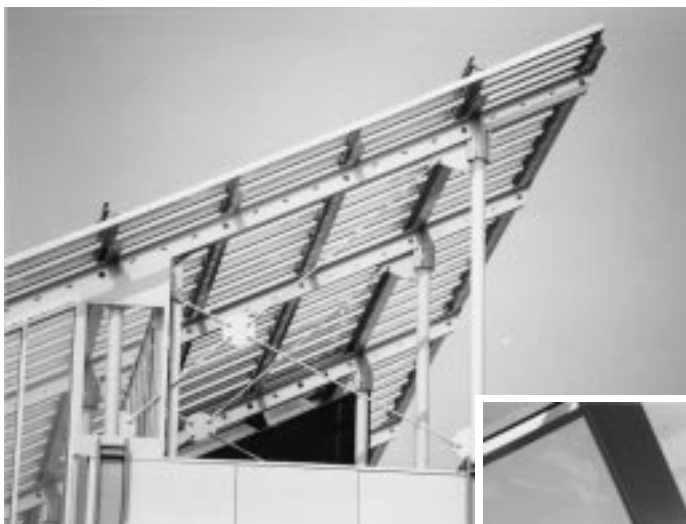
Ein verglastes Schrägdach ...
