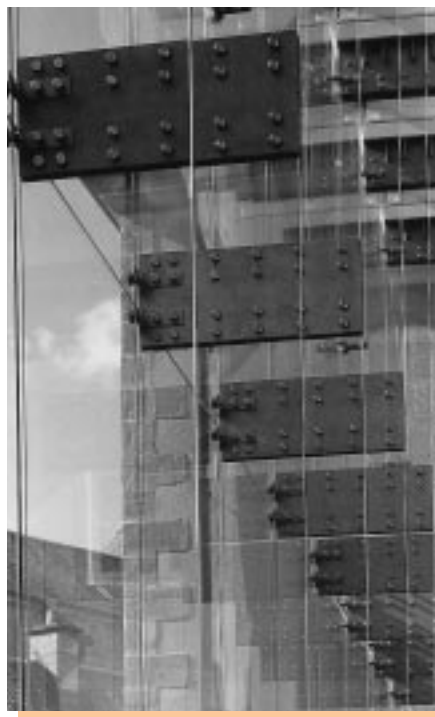
75 cm breite Schwerter aus 19 mm dickem Glas bilden die Aussteifung; aus statischen Gründen sind die Elemente mit Edelstahlblechen untereinander verbunden Fotos: Flachglas AG
