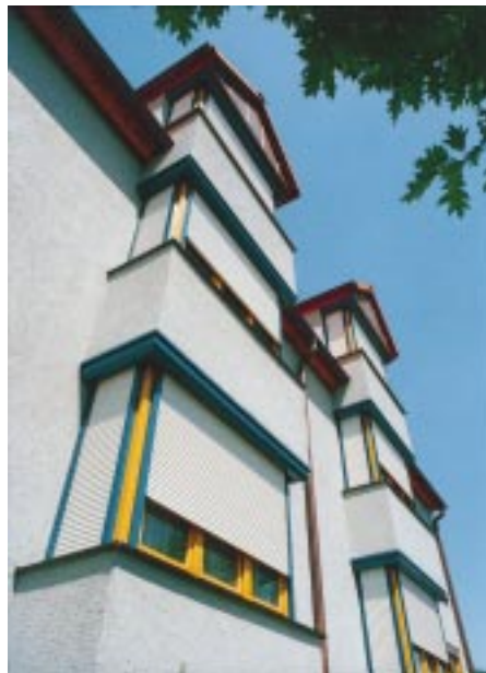
Fertig-Rolläden, Linksroller, mit abgeschrägtem Kasten, teilweise auf Gehrgung Fotos: Warema
