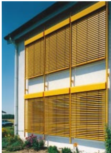
Raffstoren mit Blenden, durchgehenden Rundführungsschienen und Elektroantrieb mit Steuerung
