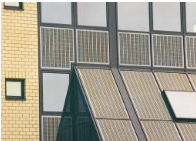
selektiver Sonnenschutzisoliervläser dar. Die Gesamtenergiedurchlässigkeit (g) des eingesetzten Sonnenschutzglases liegt mit 28 % bereits deutlich niedriger als die von unbeschichtetem Standardisoliervläs, das einen Wert von 72 % aufweist. Die Integration von Solarzellen reduziert den Wert g je nach Belegungsgrad weiter auf bis zu 17 %.
