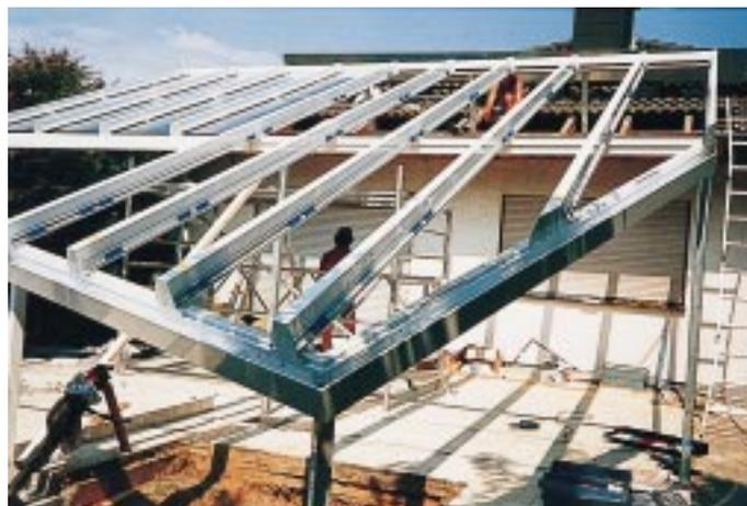
Beim Bau eines Wintergartens wird am Dach begonnen, im nachhinein werden die Türen und Fenster in die entstandenen Ausfachungen eingesetzt
